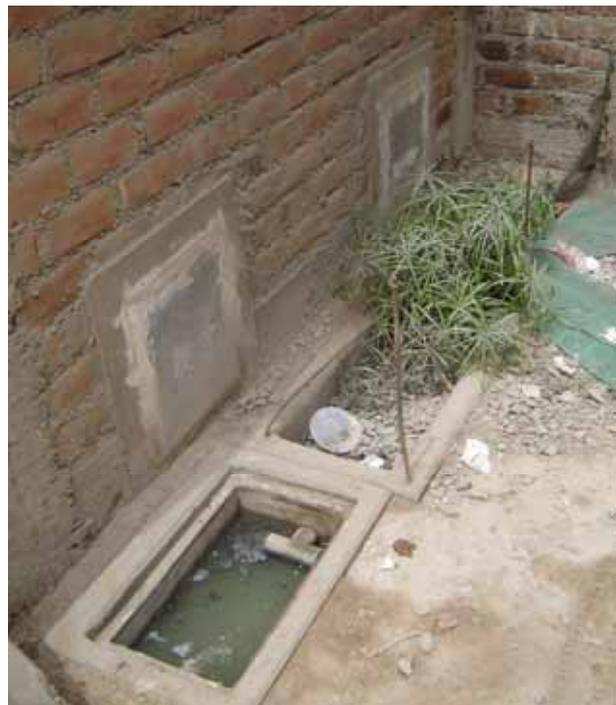
**Abb. 5-13: Reinigungseinheit bestehend aus Fettfang und Bodenfilter (Nievería)**
