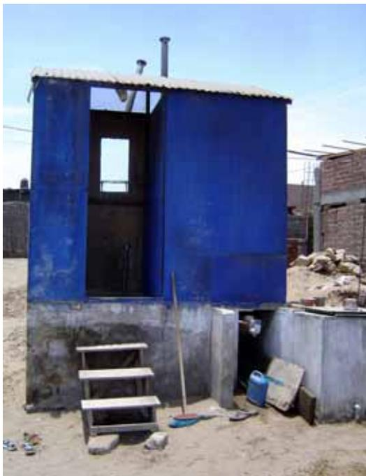
Abb. 5-8: Trockentoilettenmodul in Nueva Pachacutec (Ventanilla)
